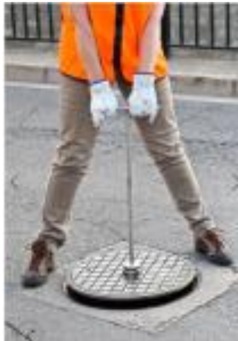
Ilustración 1. Ferramenta: imán para abrir as tapas de rexistro
