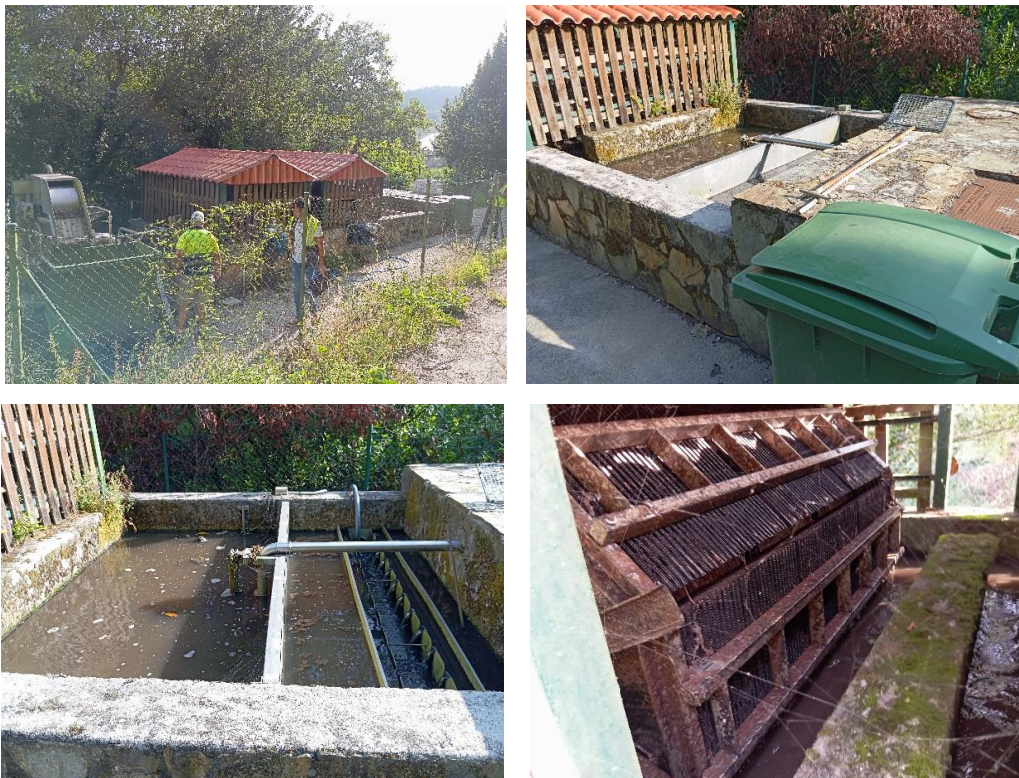
Ilustración 10. Localización EDAR DE VILAR.
